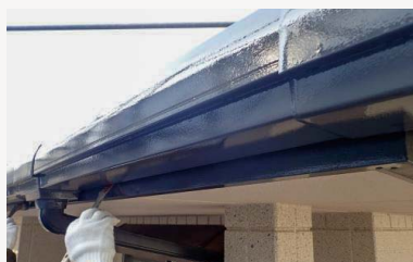
軒樋への刷毛塗装
