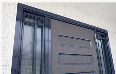
玄関枠の仕上がり外観
