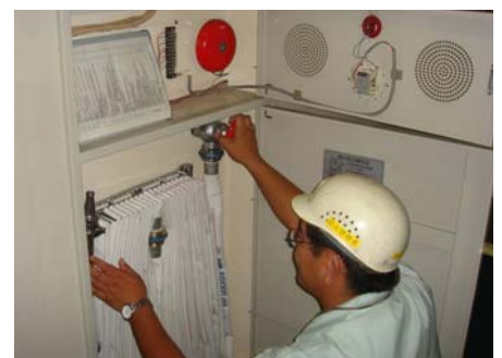
屋内消火栓の点検
