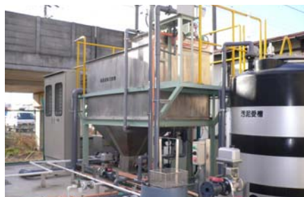
名古屋廃水処理装置
