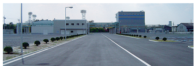
最新の安全システムを取り入れた新設FCA工場
