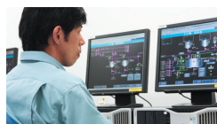
制御室のコンピュータ
