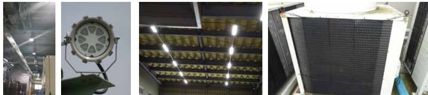
佐野事業所に導入した LED 照明 LED lighting at the Sano plant
