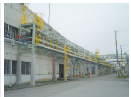
佐野事業所配管ラック更新
