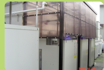
鷺宮事業所のコンプレッサーに静音タイプを導入
