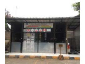
法律に従って設置した危険物廃棄前の一時保管場所
