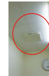
換気扇の取り付け
