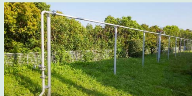
埋設から地上に設置した配管
