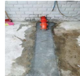
修繕した屋外埋設配管
