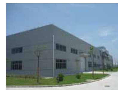
工場棟の全体風景
