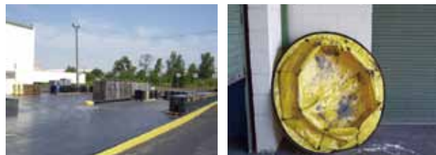
防液堤の漏水防止工事を施した廃棄溶剤処理センター（左側）と、備品としての流出防止簡易ダイク（右側）。
