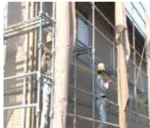
全層親綱設置工法
