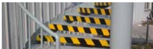
増設した安全分離帯と階段表示
