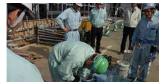
遠賀工場倉庫建設工事の上棟式典では、300tの土間コンクリート打設工事の視察と説明会も開催し、社員の業務スキルの向上を図りました。枚方工場内に仮事務所が完成し、これまでの狭かった配送業務や事務所打ち合わせの狭いフロアにあることで情報の伝達、来客への対応など改善されました。(2014.12.17開所式)
