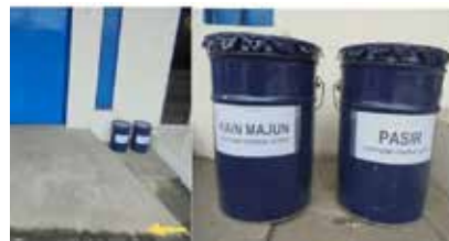
溶剤や塗料の流出防止用のウエスと砂
